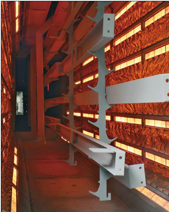
Nach der Pulverapplikation durchlaufen die beschichteten Teile eine IR-Zone und werden anschließend im 100 m langen Durchlaufofen ausgehärtet.
